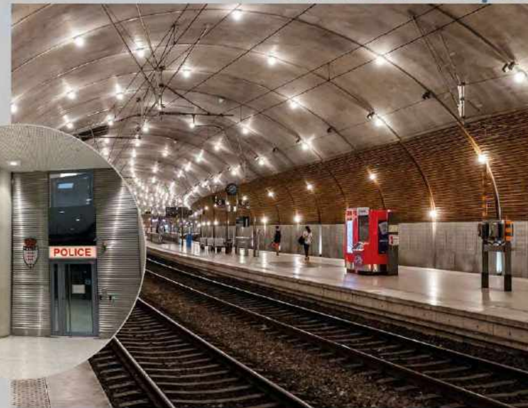
Poste de police de la gare
